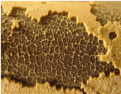
Kalkausfällung im Wärmetauscher
